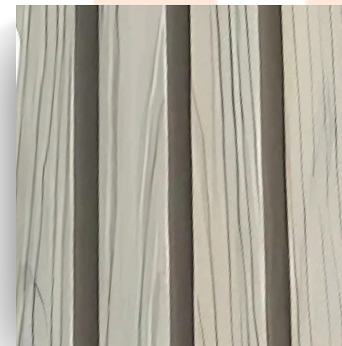
Painel Ripado DEMOLIÇÃO
